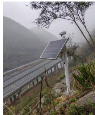
图 10 北斗接收机安装
