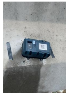
图 8 视频裂缝计安装
