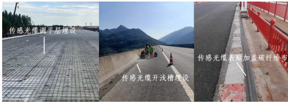
图 4 新建、既有桥梁传感器安装方式
