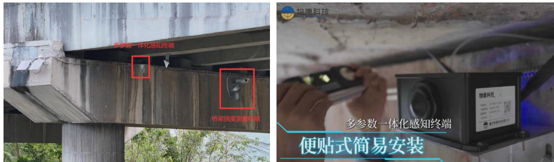
图 4 土地垭大桥设备安装图
