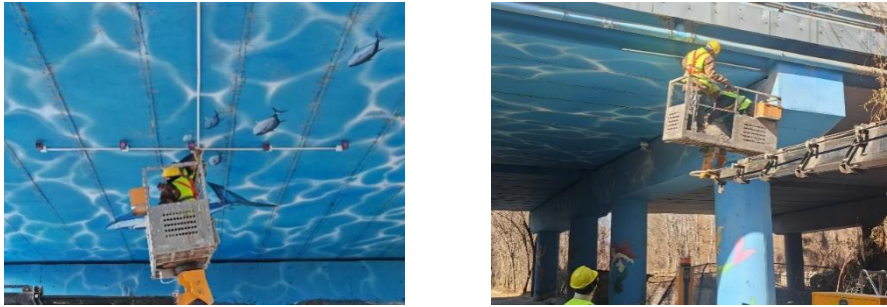
图 1 非接触在线监测相机安装过程
