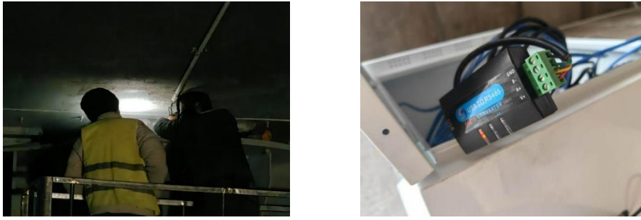
图 4 倾角仪安装过程
