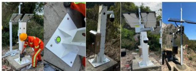
图 11 桥侧崩塌落石识别与预警
