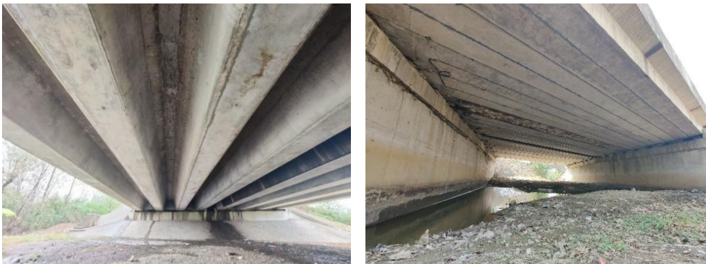
图 6 光栅阵列应变传感光缆布设现场
