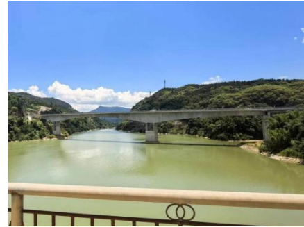
图 2 国道 205 线南平市曲港大桥现场图
