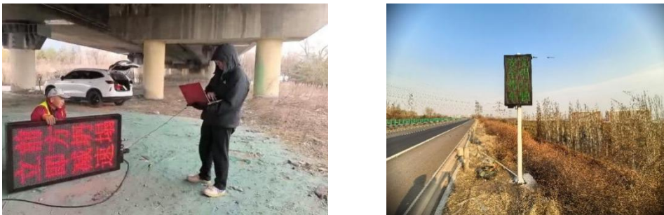
图 6 情报板安装过程
