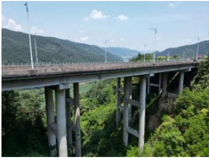
图 1 三明市国道 205 线梅列红 3 号大桥(下行)现场图
