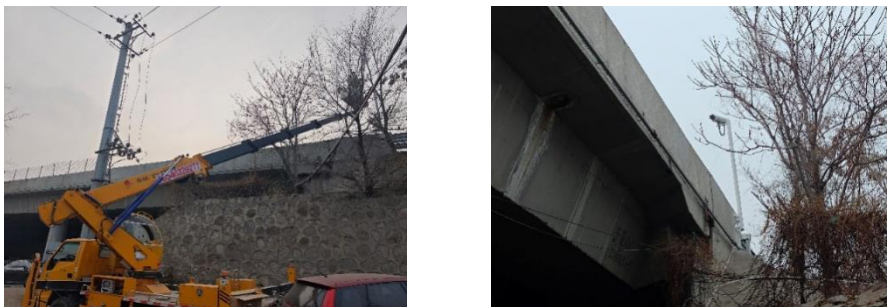
图 3 桥面事件检测相机安装过程
