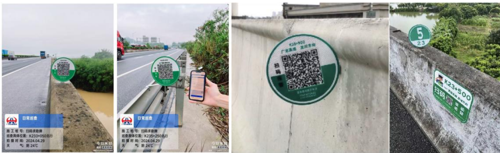
图 2 数字百米桩安装效果图
