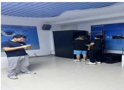
瑶北机房设备安装
