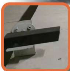
隧道 自动化监测
