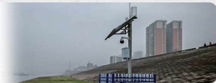
水库大坝 自动化监测
